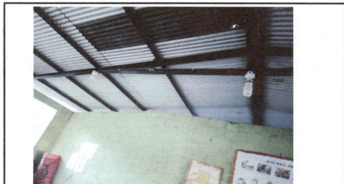
Foto 4: cubiertos de laminas y estructuras de techos
